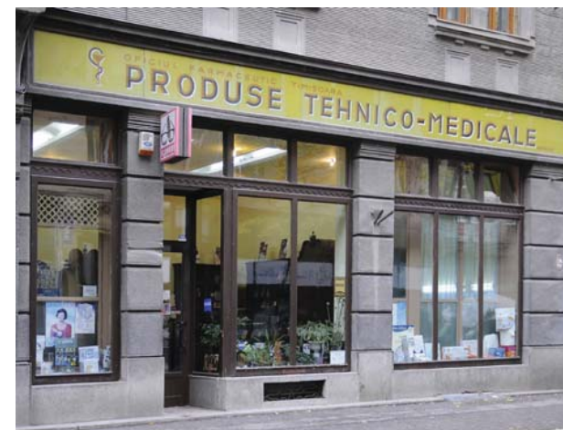
Fig. 3.8 Suprafață de reclamă extinsă pe întreaga lungime a vitrinelor. Reclama, compusă pe sticlă tratată pe verso, este prinsă între cercevele din lemn.
