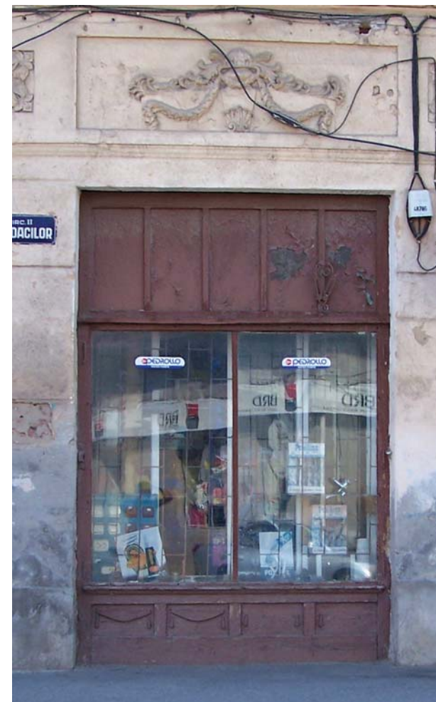
Fig. 2.4 Vitrină simplă, cu format compact Vitrină din perioada anilor 1900 a cărei suprafață ajunge până la nivelul trotuarului. Oberlihtul este împărțit prin șprosuri verticale. Socul este realizat din elemente de lemn cu ornamentații aplicate.
