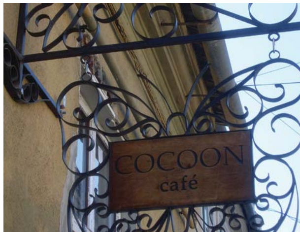
Fig. 3.12 Reclamă în executată în manieră istoricistă, din bandă de fier forjat. Textul este incizat pe o suprafață din lemn.
