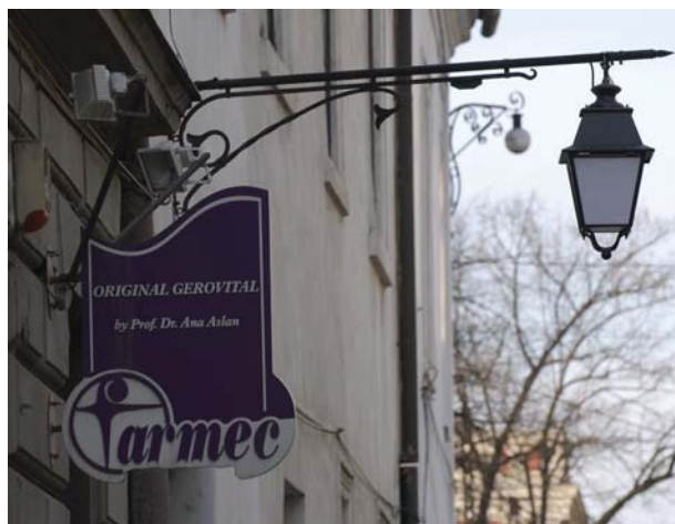
Fig. 2.121 Compoziția iese puternic din planul fațadei, în consolă. Ea este realizată cu elemente din fier forjat și un corp de iluminat simplu din sticlă camee, care se evazează la partea superioară. Instalația susține totodată și panoul de reclamă cu firma magazinului.
