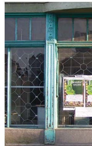
Fig. 2.91 Stâlp de susținere din perioada anilor 1900 placat cu decorațiuni geometrizate
