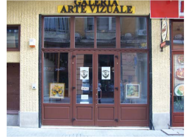
Fig. 2.127 În acest caz au fost respectate dimensiunile inițiale și subîmpărțirile. Din păcate au fost utilizate elemente din PVC în loc de feronerie. Acestea nu concordă cu imaginea istorică în ansamblu.
