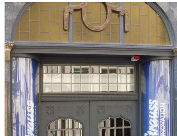
Fig. 2.82 Oberlihtul în formă de arc al acestui acces reprezentativ într-un magazin, este bogat ornamentat cu sticlă specială colorată, șprosuri metalice și decorație aplicată, din alamă. Suprafețele pătrate din sticlă ale oberlihtului ușii au fațete șlefuite. Ele sunt de asemenea fixate cu șprosuri metalice.
