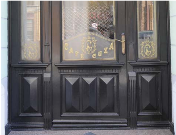
Fig. 2.96 Blatul din lemn din partea inferioară este ornamentat cu bosaje în așa numita „tăietură de diamant”, tipică pentru stilul istoricist.
