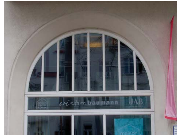
Fig. 2.85 Tratarea și articularea plastică a acestei vitrine cu forme discrete, simple, care coboară până la nivelul parterului, este dominată de cele 7 șprosuri verticale din zona arcului în plin cintru al oberlihtului.
