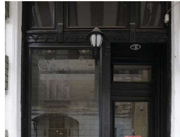
Fig. 2.119 Corp de iluminat amplasat central, cu suport inferior din fontă cu elemente verticale, care susțin corpul lămpii din sticlă camee albă.
