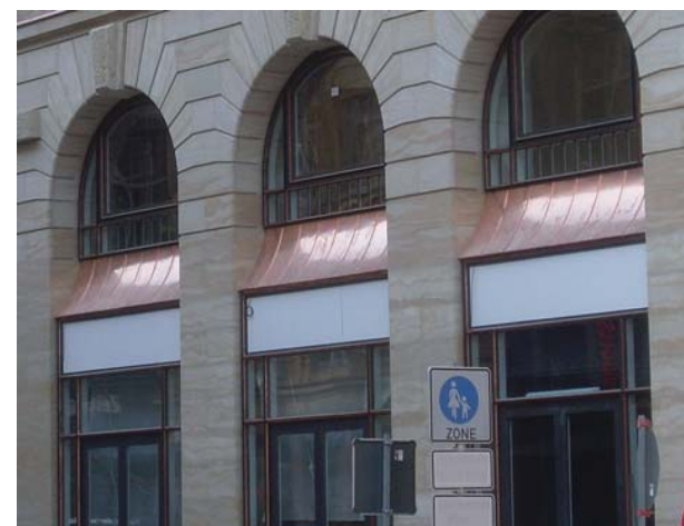
Fig. 2.117 Vitrinele, înalte de peste 6 metri sunt amenajate, în partea inferioară, în planul fațadei. La partea superioară, ele sunt retrase din planul fațadei. Decalajul de adâncime este acoperit cu un șorț din tablă de cupru cu o formă arcuită decorativă. Din necesitatea de a proteja vitrina față de intemperii a rezultat o împărțire și o rezolvare plastică reușită a compoziției.
