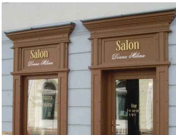
Fig. 3.19 Textul reclamei este constituit din litere masive din alamă și din litere unduite albe, integrate în suprafața delimitată de profile din lemn.
