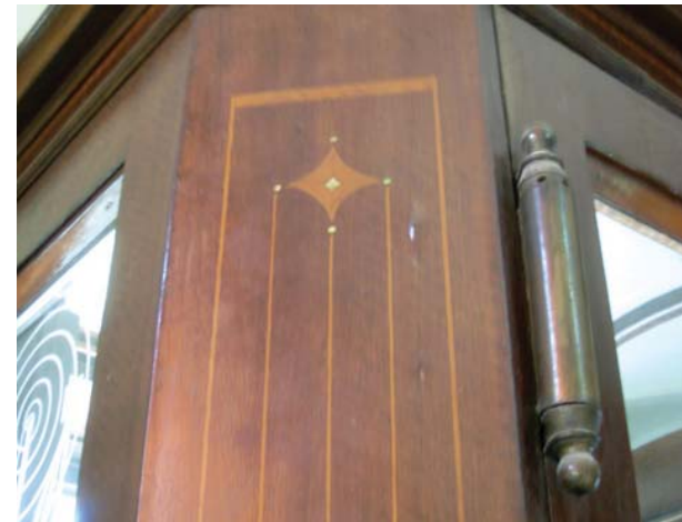
Fig. 2.114 Vindfangul se continuă și în interior, furniruit cu lemn de esență nobilă și intarsii din lemn de culoare mai deschisă și din sidef. Compoziția unitară a vitrinelor și intrării se continuă și în amenajarea interioară a magazinului.
