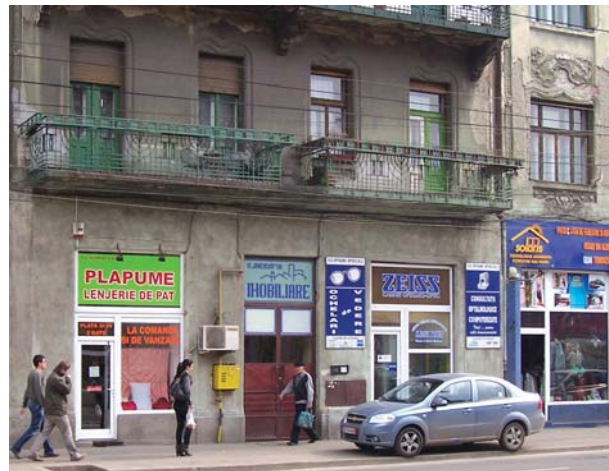
Fig. 2.129 Greșit! Toate vitrinele sunt în disonanță cu fațada impunătoare din perioada anilor 1900. Atât materialele utilizate, cât și proporțiile și culorile sunt în disonanță cu restul fațadei.
