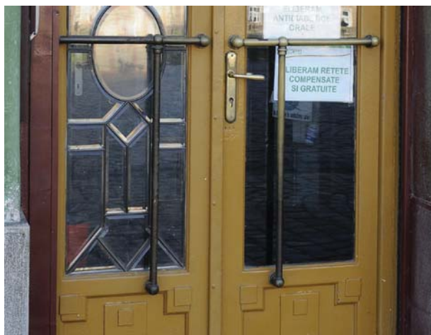
Fig. 2.106 Mânere perpendiculare din alamă Compoziție care corespunde atât arhitecturii anilor 1900, cât și stilului Art Deco
