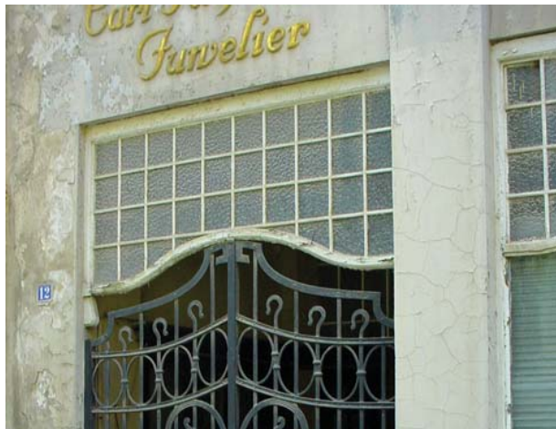
Fig. 2.113 Oberlihtul este executat din lemn și reia modelul montat deasupra vitrinelor alăturate. Poarta pentru accesul de livrare a mărfurilor, din partea inferioară a compoziției, este închisă cu o ușă cu ornamente din fier forjat.
