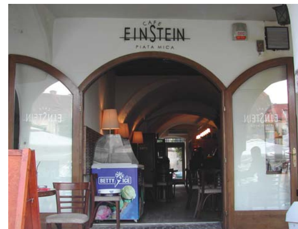
Fig. 3.21 Literele separate aplicate direct pe fațadă subliniază reclama prin iluminare discretă indirectă, fără să aibă un efect negativ asupra fațadei.
