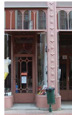
Fig. 2.92 Stâlp de susținere din metal placat cu ornamente nituite
