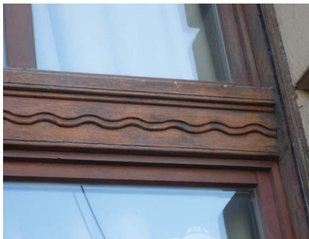
Fig. 2.94 Profil de traversă de la o vitrină din perioada anilor 1900, tratat în mod simplu, dar marcant, în forma unei unduii duble.
