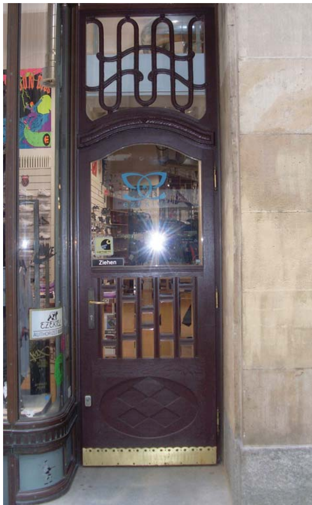
Fig. 2.38 Ușă cu un canat cu parte laterală vitrată cu sticlă cu cercevele curbate
