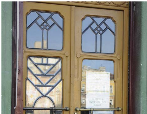
Fig. 2.78 Suprafețele mici din sticlă transparentă sunt fixate cu șprosuri din alamă sudate între ele. Acest exemplu prezintă o compoziție foarte reușită a arhitecturii anilor 1900 – Jugendstil târziu, care anunță limbajul formal al stilului Art Deco.
