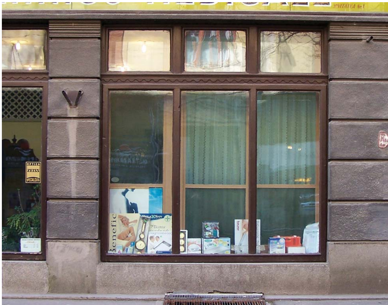
Fig. 2.3 Vitrină simplă, cu format compact, cu rame (cercevele) din lemn de stejar lazurat, cu traverse cu ornamente tipice stilului anilor 1900 (Jugendstil) în forma unor linii unduie. Împărțirea oberlihtului cu canaturi mobile, se continuă și în partea inferioară.
