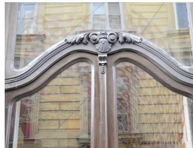
Fig. 2.95 Traversă arcuită ca despărțire între o ușă cu două canaturi și un oberliht în stil neobaroc. Sculpturi în lemn formează încheierea superioară a axului central al compoziției.
