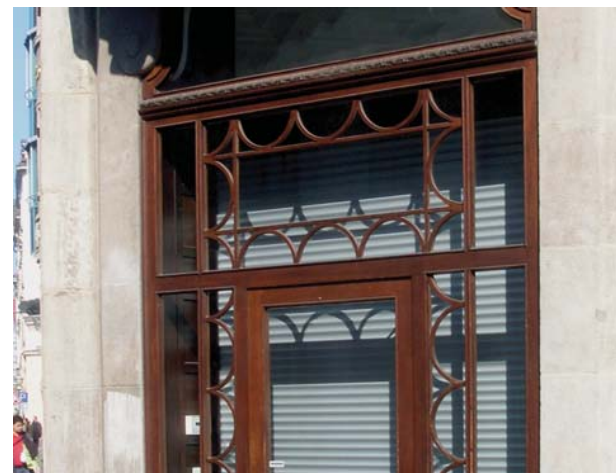
Fig. 2.88 Compoziție cu șprosuri de formă dreaptă și semicirculară, tratate migălos, amplasată la intrarea unui magazin. Ușa este executată din lemn de stejar lazurat. Combinația meșteșugită a șprosurilor atrage privirea asupra acestei compoziții, având o suprafață de peste 6 m 2 .
