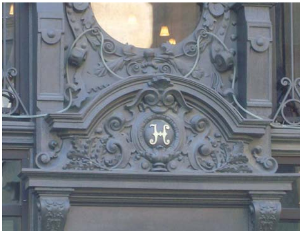
Fig. 2.99 Elementul montat între ușa de intrare și oberlihtul rotund, cu un antablament neobaroc arcuit, puternic profilat, este bogat ornamentat cu podoabe din lemn sculptat. Partea centrală este destinată amplasării inițialelor proprietarului.
