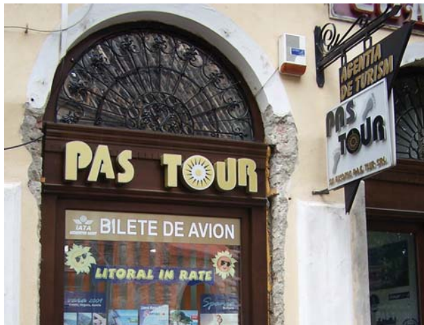
Fig. 2.128 În acest caz vitrinele au fost reamenajate adecvat. Elementele de feronerie de la nivelul oberlihtului și reclama au fost bine încadrate. Din păcate ancadramentul a fost distrus și trebuie reconstruit.
