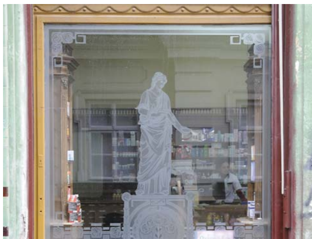
Fig. 2.80 Sticlă tratată ornamental la vitrina unei farmacie. Suprafețele vitrate, sablate sau tratate chimic, cu indicarea numelui proprietarului magazinului sau cu însemne ale profesiunii sale se realizau printr-o tratare minuțioasă. Realizate cu migăla, ele constituie o reflectare a dorinței proprietarilor de a prezenta o compoziție plastică deosebită, distinctivă a vitrinelor.
