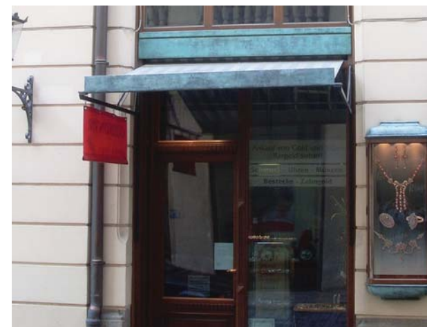
Fig. 2.112 Copertina din material textil pentru protecția împotriva razelor de soare. Ea este integrată foarte abil în elementul orizontal care acoperă intrarea și vitrina. Materialul copertinei este același ca și cel care plachează elementul orizontal, așa încât copertină rulată nu este vizibilă.
