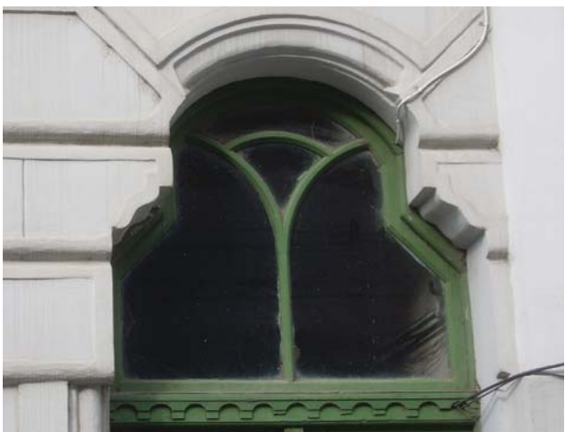
Fig. 2.86 Șprosurile în stilul arhitecturii anilor 1900 amplasate deasupra traversei decorate cu profiluri unduite subliniază forma arcuită a oberlihtului acestei uși. Ele se integrează armonios în compoziția de ansamblu a fațadei.
