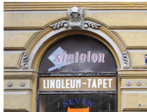
Fig. 2.70 Tipul 2: Arcul semicircular sau „arc în plin centru” Aici arcul reprezintă un semicerc complet, care se termină de cele mai multe ori la elementul de traversă.
