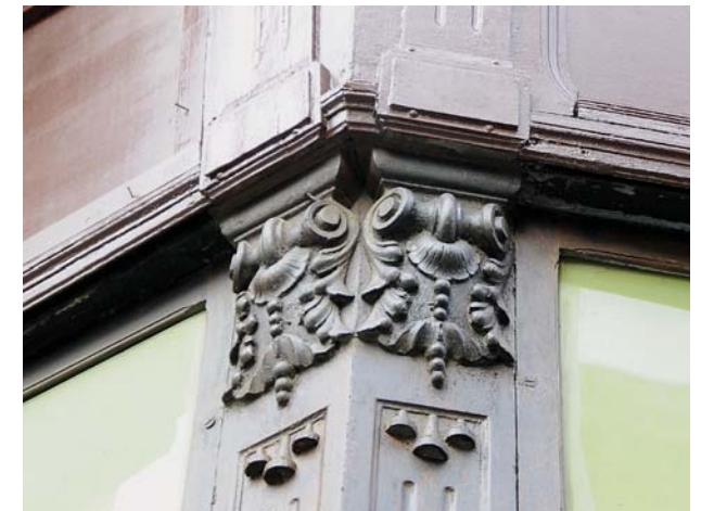
Fig. 2.101 Placarea cu elemente verticale a unui colț de clădire este încheiată la partea superioară cu capiteluri bogat modelate.
