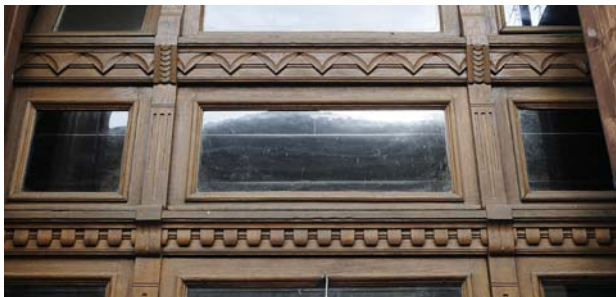
Fig. 2.93 Cele două traverse ale acestei vitrine au fost tratate voit în mod diferit. Traversa de la partea inferioară este decorată cu o friză cu denticuli, cea superioară cu segmente de arcuri. Elementele ornamentale verticale relativ simple, leagă compozițional cele două traverse.
