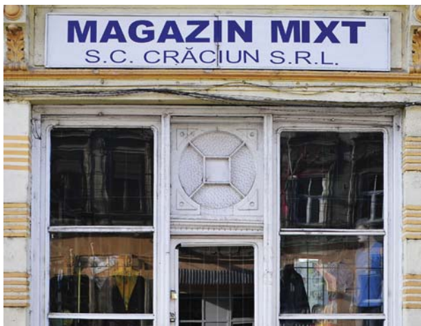
Fig. 2.87 Oberlihtul unei uși cu o formă geometrizzantă simplă este decorat cu un ornament în forma unui cerc. Din păcate, pe suprafața din sticlă sablată a fost aplicat ulterior un strat de vopsea. Este foarte probabil, că și șprosurile orizontale ale vitrinelor au fost montate ulterior.
