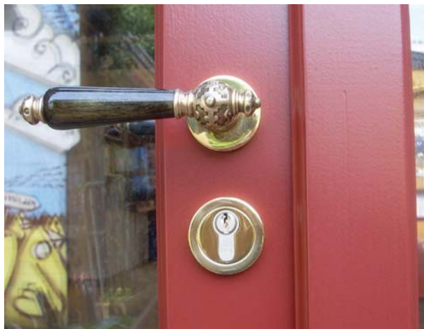
Fig. 2.102 Clanță și încuietoare (zăvor) Garnitură de clanță din alamă și „opal de corn”, din jurul anilor 1890. Clanțele sunt combinate cu un zăvor și o rozetă din alamă contemporane.
