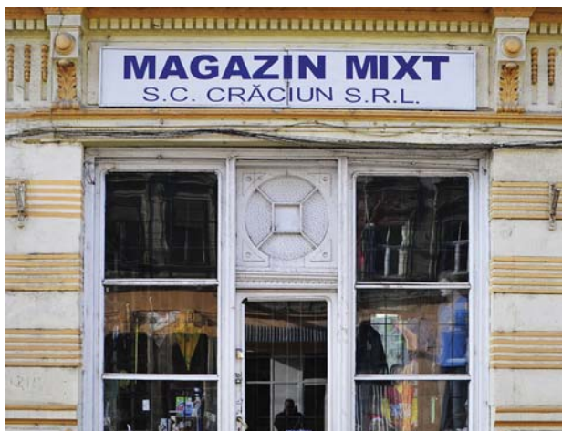
Fig. 3.9 Suprafața pentru reclame, încadrată de elemente de decor artistic executate în stilul "Neorenașterii", situată deasupra vitrinelor compuse simetric, oferă un spațiu vizibil pentru o reclamă optimă.
