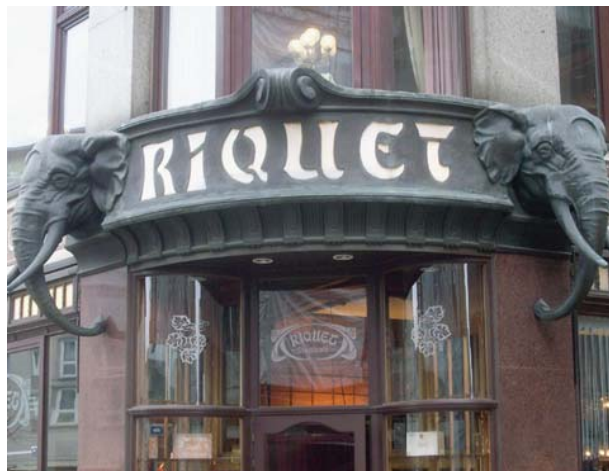
Fig. 3.22 Suprafața destinată reclamei de deasupra intrării magazinului este executată artistic din aramă. Textul, scris cu litere caracteristice stilului anilor 1900, luminate indirect, este acoperit cu sticlă de camee albă. Capetele de elefanți indică utilizarea din trecut a magazinului: comerțul cu mărfuri din India.
