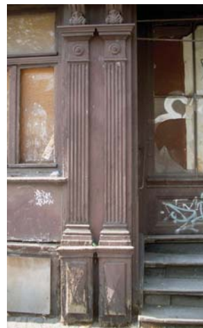
Fig. 2.90 Stâlpi din zidărie, care flanchează această vitrină din jurul anilor 1880 sunt placați cu pilaștri din lemn, tratați în stil clasicist
