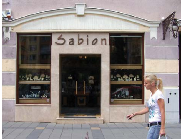
Fig. 2.125 Reamenajare: vitrina istorică a primit în acest caz o nouă interpretare. Se păstrează dimensiunile golurilor și simetria inițială. Corpurile de iluminat istorice se integrează armonic în imaginea în ansamblu.
