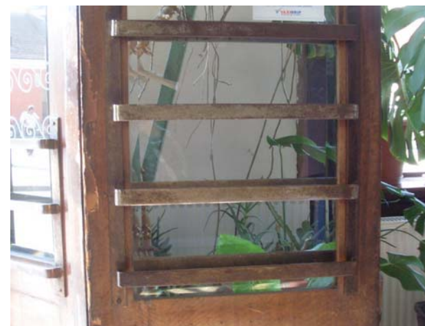
Fig. 2.107 Mânere simple, dar având dimensiuni relativ mari, cu forme geometrice, datând din perioada de după anul 1900. Protejează suprafața vitrată a ușii și evidențiază intrarea.
