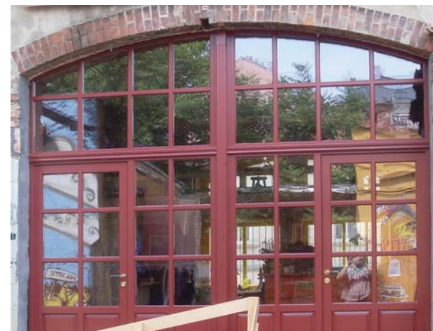
Fig. 2.69 Tipul 1: Arcul segment de cerc Arcul este doar un segment al unui cerc de ample dimensiuni.
