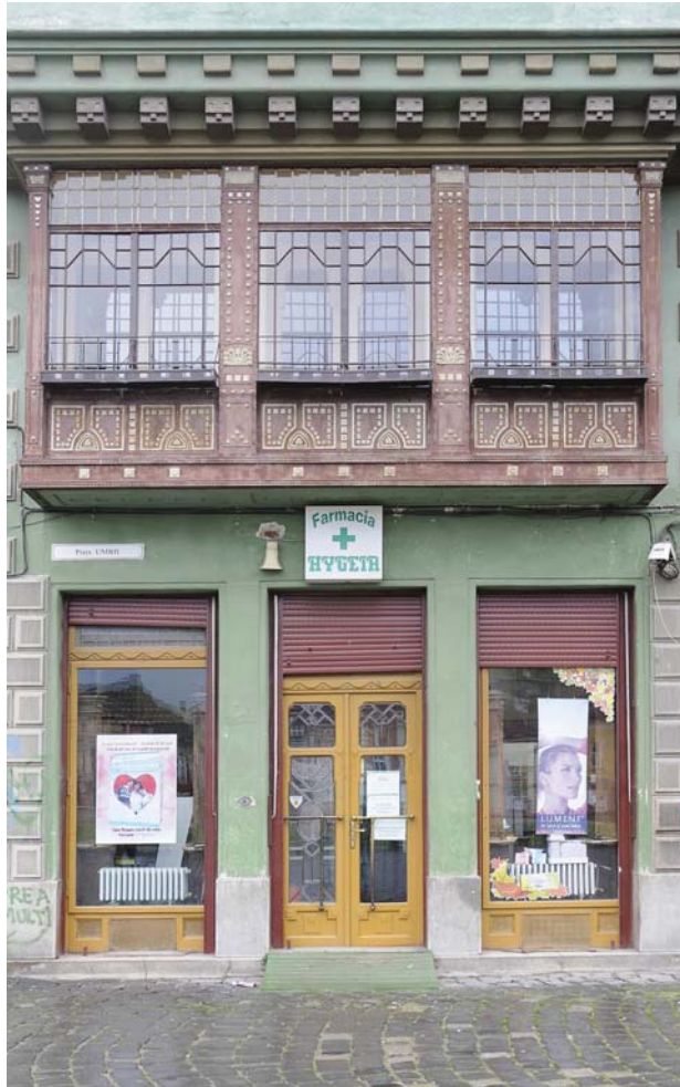
Fig. 2.25 Poartă, vitrine și pilaștri de zidărie ca unitate compozițională simetrică
