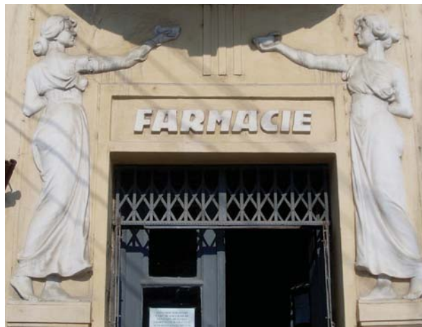
Fig. 2.108 Oberlihtul acestei farmacie este protejat cu un grilaj „în formă de foarfecă”, care se poate plia deasupra ușii de intrare. În unele cazuri, grilajul poate fi ascuns într-o fantă executată în zidărie.
