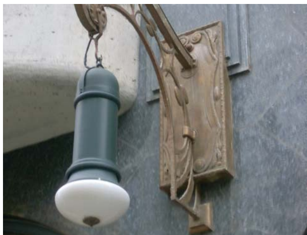
Fig. 2.120 Iluminare bogat decorată, din faza de maximă înflorire a arhitecturii anilor 1900. Elemente turnate sau forjate de alamă, fier tratat special și sticla camee albă a lămpii sunt combinate în acest exemplu în mod fericit.
