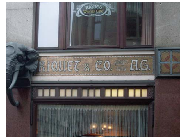
Fig. 3.23 La aceeași clădire apar și alte texte de reclamă deasupra vitrinelor, pe suprafețe executate în tehnică specială de mozaic ceramic. Textul, integrat suprafeței de mozaic, este realizat în aceeași tehnică.
