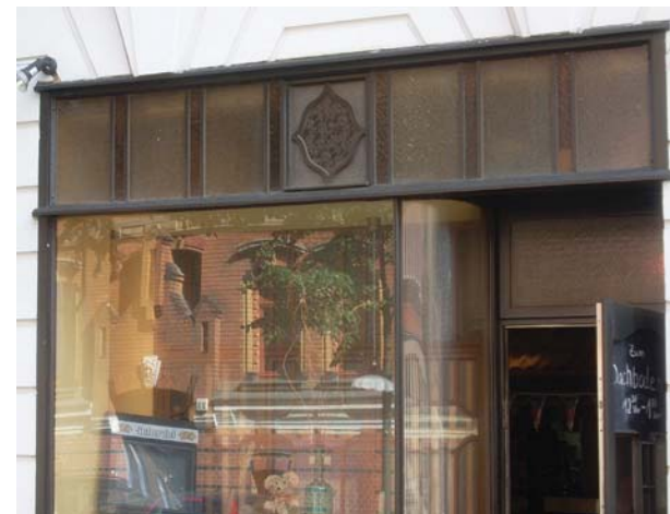
Fig. 2.79 Sticlă laminată, cu șprosuri tratate migălos, amplasate pe întreaga lățime a oberlihtului. Legătura între ușa retrasă din planul fațadei și vitrină se realizează printr-o suprafață arcuită de sticlă.
