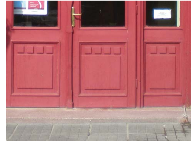
Fig. 2.98 Blaturi plate cu aplicații ornamentale, de formă pătrată. Blaturile sunt fixate și rigidizate prin șipci profilate.
