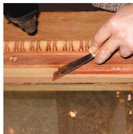
Îndepărtarea vopselei cu aer fierbinte
