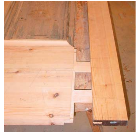
Îmbinare nouă în lemn, executată în tehnologie tradițională manufacturieră.
