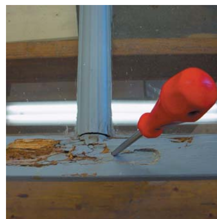
Probleme de durabilitate create de vopseala pe bază de rășini sintetice
