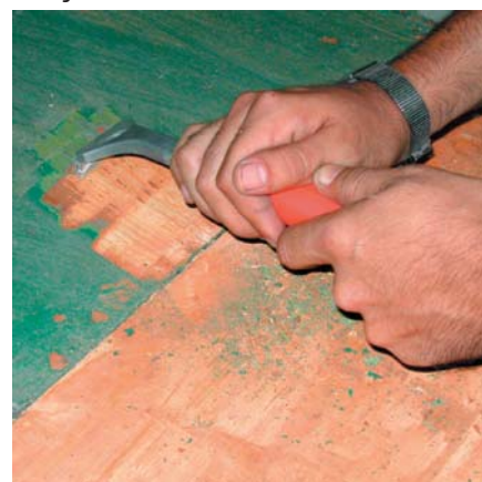
Îndepărtarea vopselei cu răzuitorul / rașcheta
