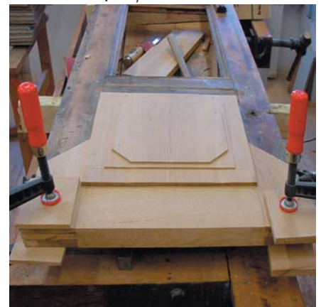
Înlocuirea părților distruse
